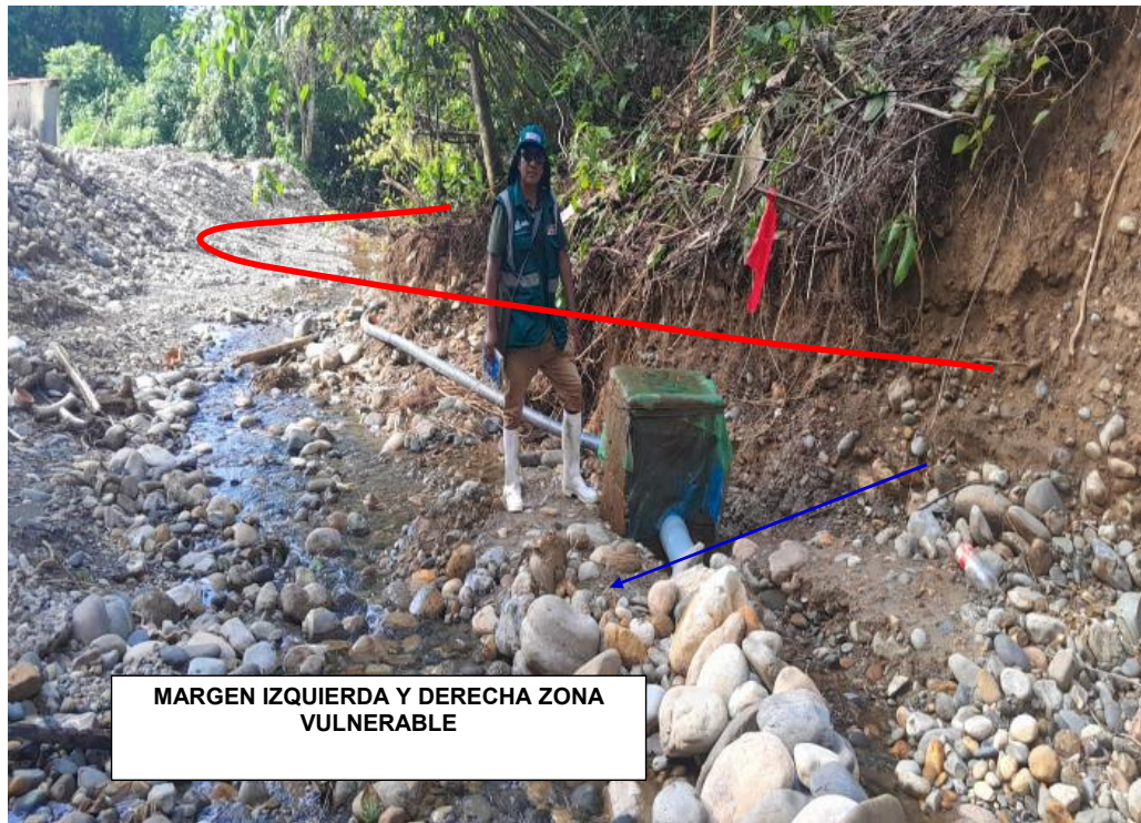
FIGURA N° 01: TRAMO CRÍTICO EN LA QUEBRADA GAMARRA, SE APRECIA LA SOCAVACIÓN DE LA MARGEN DERECHA.
