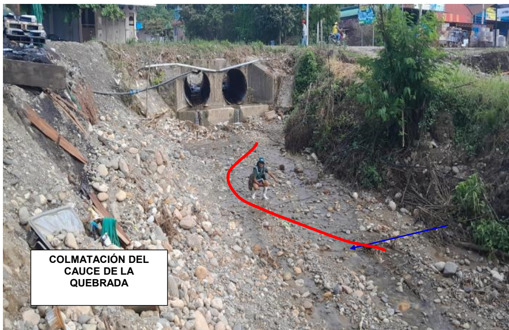
FIGURA N° 02: SE APRECIA LA COLMATACIÓN DEL CAUCE DE LA QUEBRADA GAMARRA
